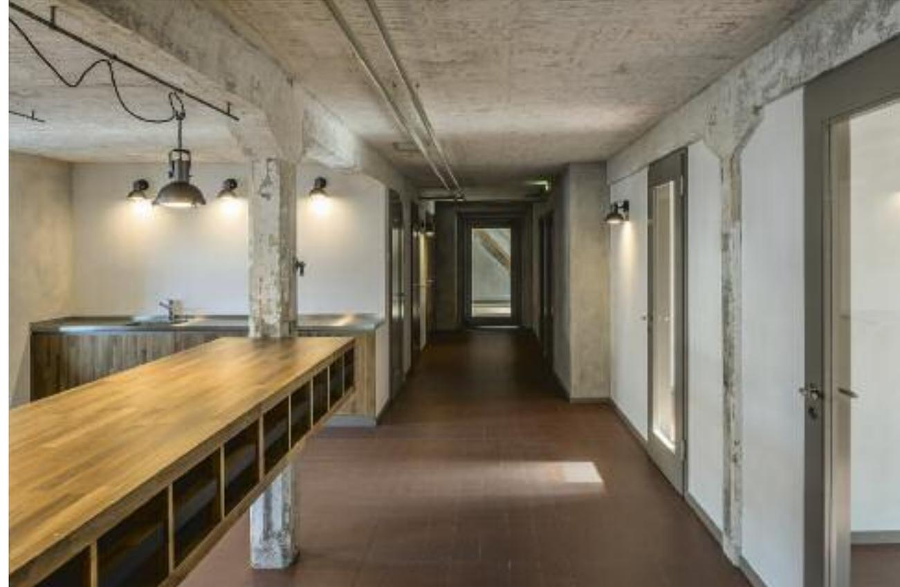
Das historische Hauptgebäude wurde in einer denkmalpflegerischen Haltung in seinen Originalzustand zurückgebaut. Im Erdgeschoss wurde die historische Betontragstruktur mit der Hourdisdecke freigelegt und im offenen Mitarbeiterraum räumlich erlebbar gemacht. Die bauliche Erneuerung und die Einbauten aus Gips und Holz erfolgten in einer Haltung des Weiterbaus. Die Wertigkeit und die Identität des Bestandes wurden so erhalten und gestärkt.
