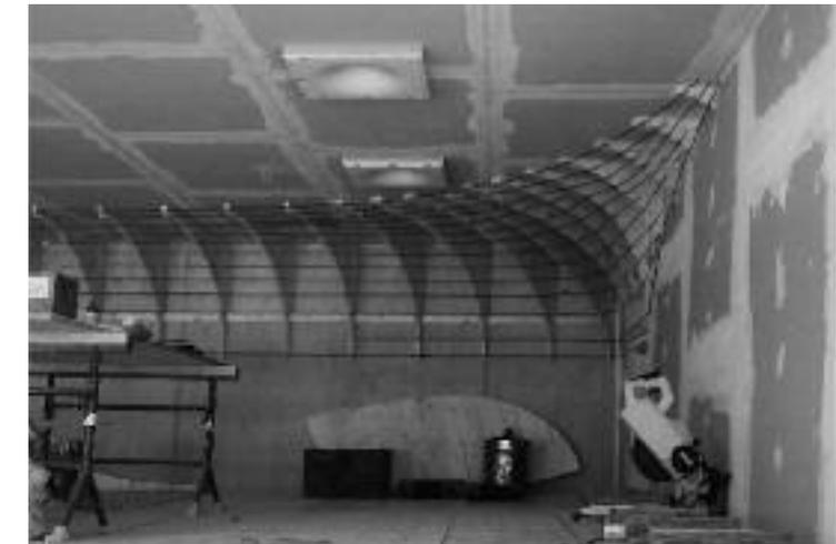
Die doppelt gewölbte Decke Forum mit klassischer Putzträgerkonstruktion aus Holzknaggen, Rundeisen und Ziegelrabitzgeflecht
